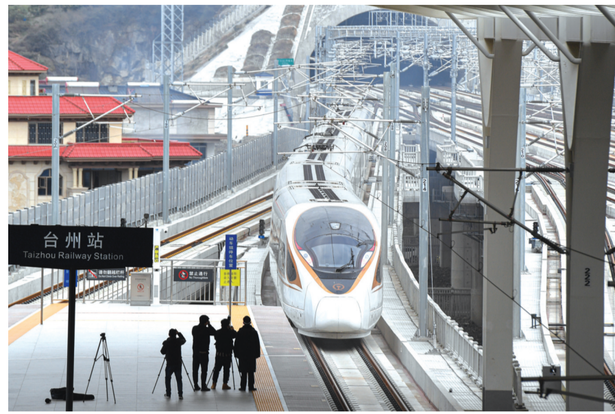
1月8日,我国首条民营控股高铁——杭台高铁首发列车从台州站驶出。
