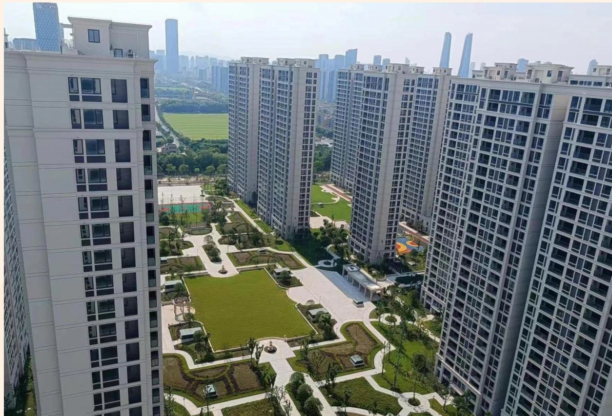
在工行省分行和萧山分行牵头的银团贷款支持下,宁围街道金一、金二、宁东、宁税社区的拆迁与安置工作顺利推进,如期竣工
