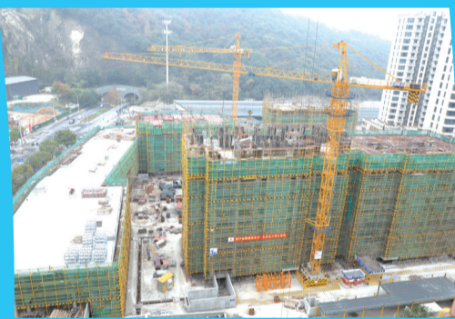
高田安置房工程
