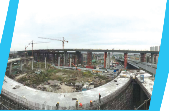
03省道东复线高架南延工程
