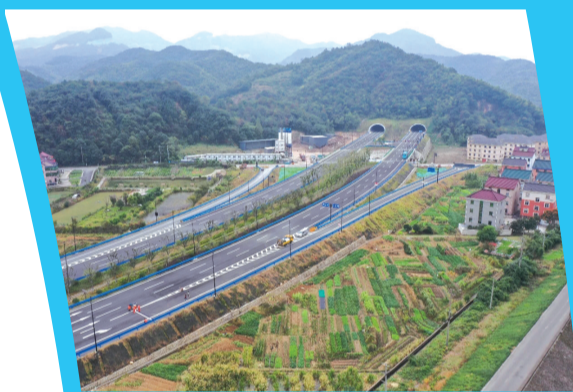
03省道改建工程
