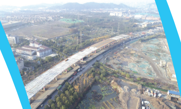
时代大道改建工程
