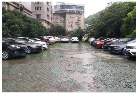
馨星大厦小区广场整治前
