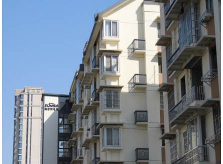
老旧小区改造后的广德小区
