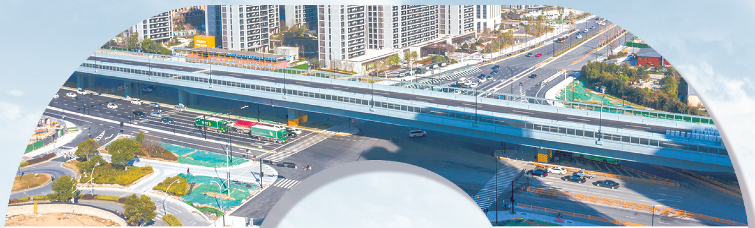
风情大道改建工程完成总进度 50%
