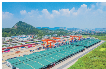
萧山铁路货场整合及专用线迁白鹿塘项目
