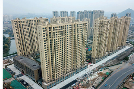
顺和悦府—城里吴安置房项目顺利竣工分房
