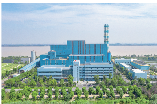
萧山垃圾焚烧发电项目
