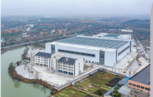
南部固废资源化利用综合体项目投入试运行
