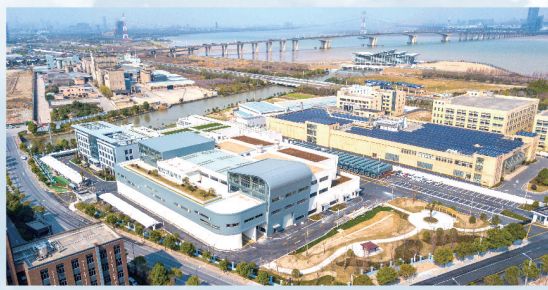
绿色循环综合体项目投入试运行
