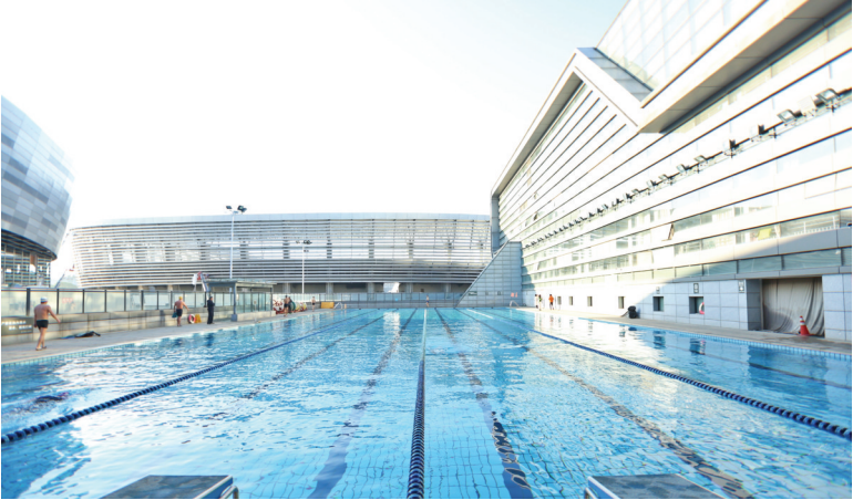
区体育中心室外游泳馆
