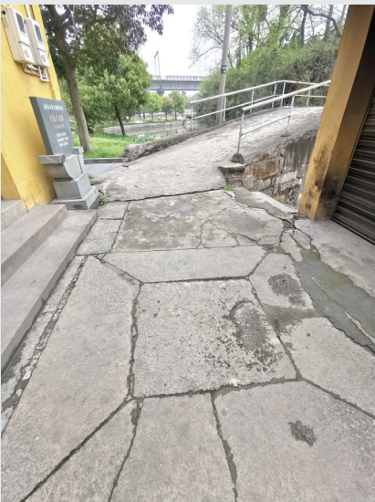
浴美施桥北桥堍
