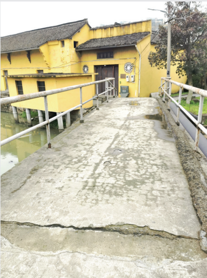
浴美施桥桥面
