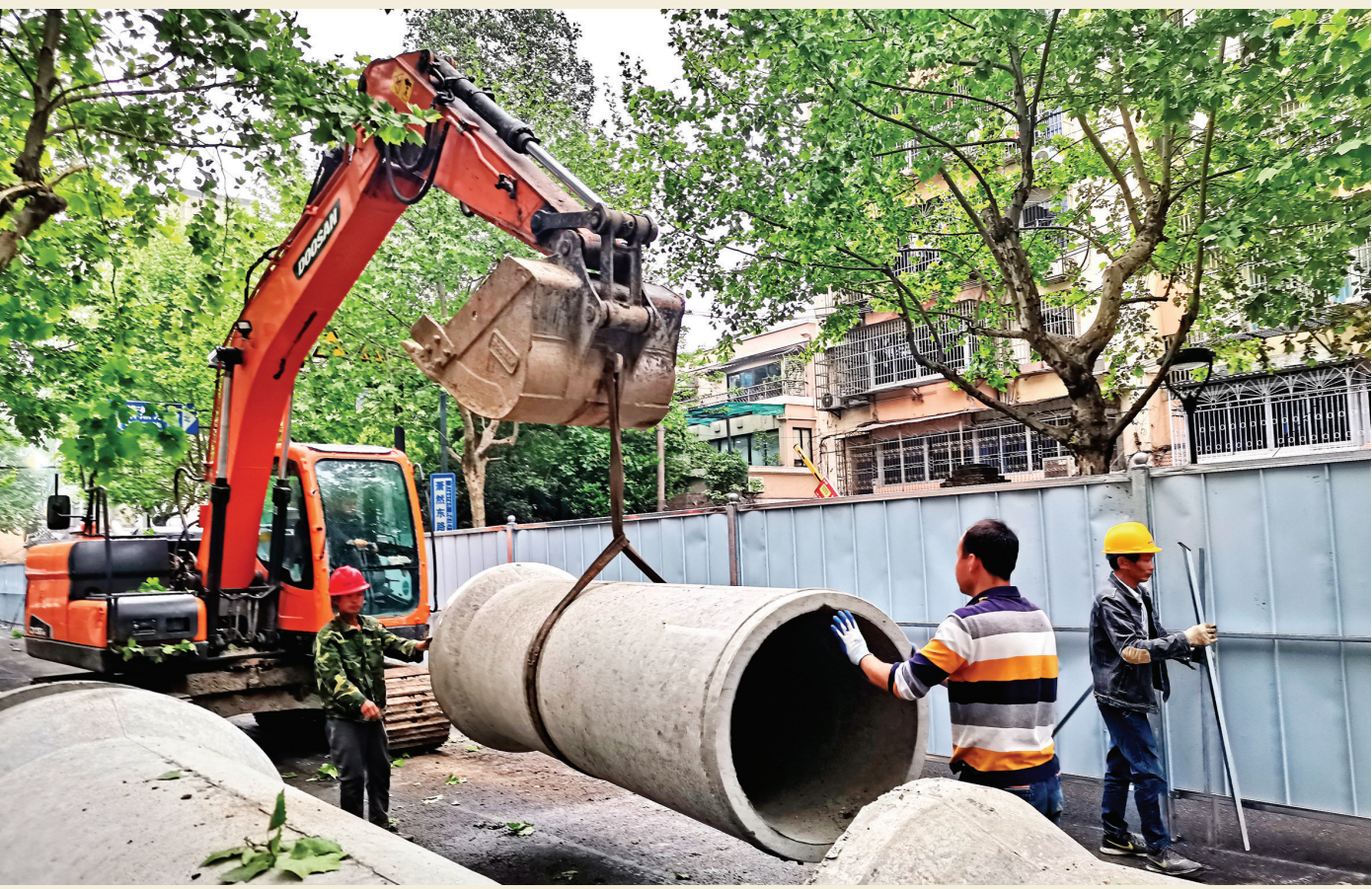
昨日,市政工人在梅花弄铺设新的排水管道,确保老城区汛期排水畅通。 记者 丁毅 摄
