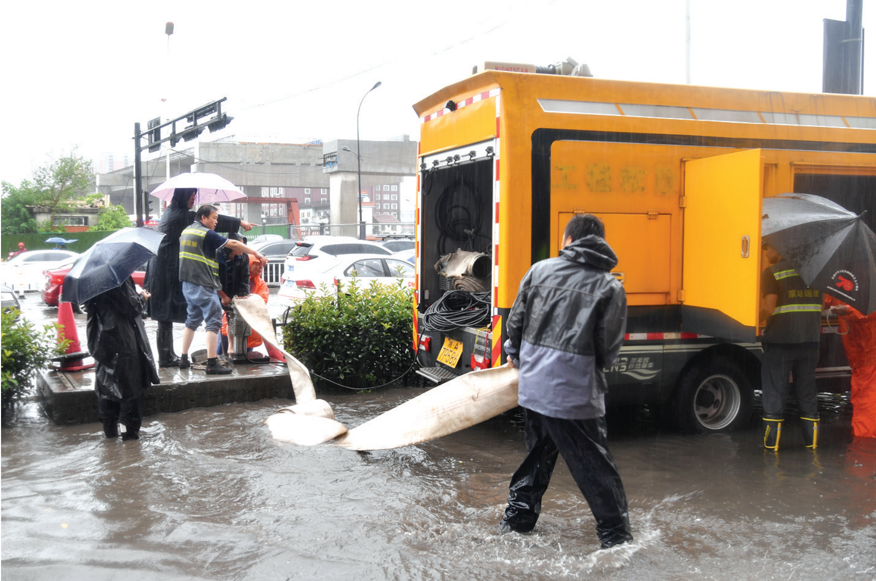
建设四路通惠路东积水点排水。 记者 范方斌 摄
