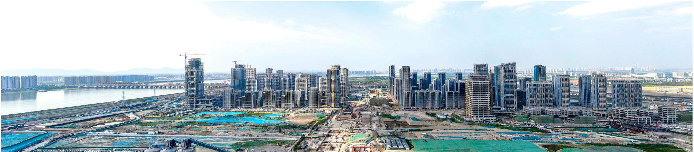
建设中的亚运村
