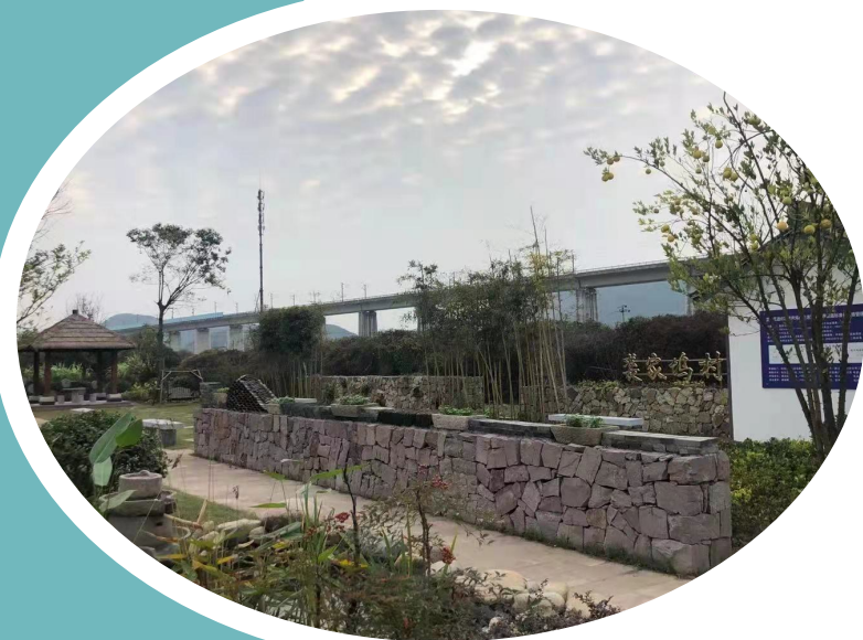
进化镇裴家坞村污水处理设施
