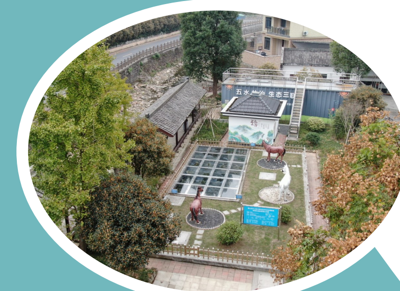
河上镇三联村生活污水处理设施
