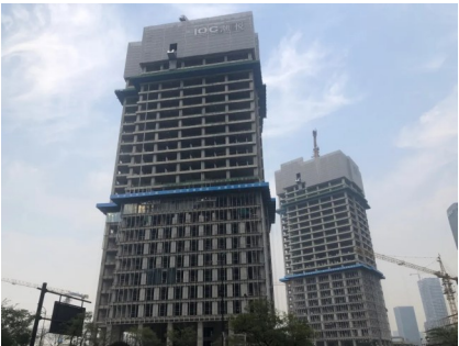
项目工程实景图
