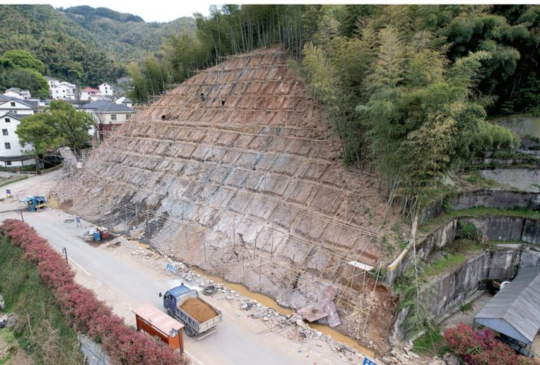
河上镇东山村一处地质灾害治理点正在削坡减负、锚杆注浆、格构梁及喷播等施工,预计汛期前基本完成治理。
