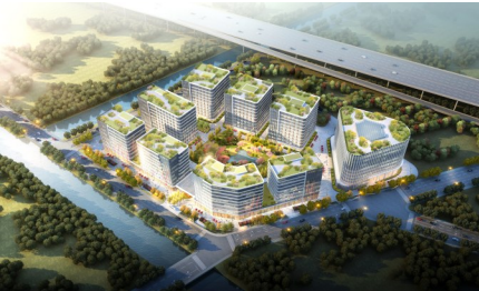
正在建设的钱江电气电力生态产业园(效果图)
