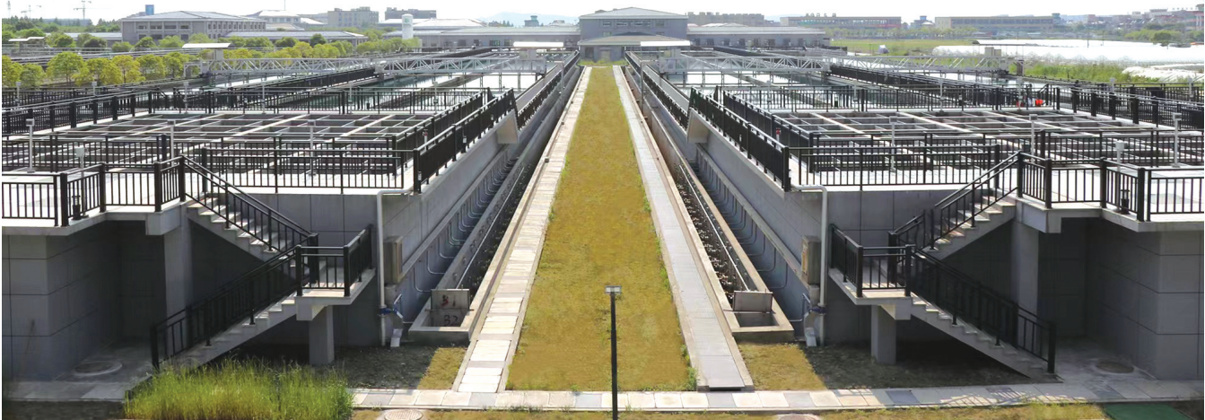
2022年5月,江东水厂二期改扩建工程顺利调试通水。图为新建成的沉淀池。
