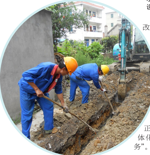
2011年起,萧山环境集团深入实施农村供水“一户一表”改造工程。图为所前镇金临湖工程改造现场。
