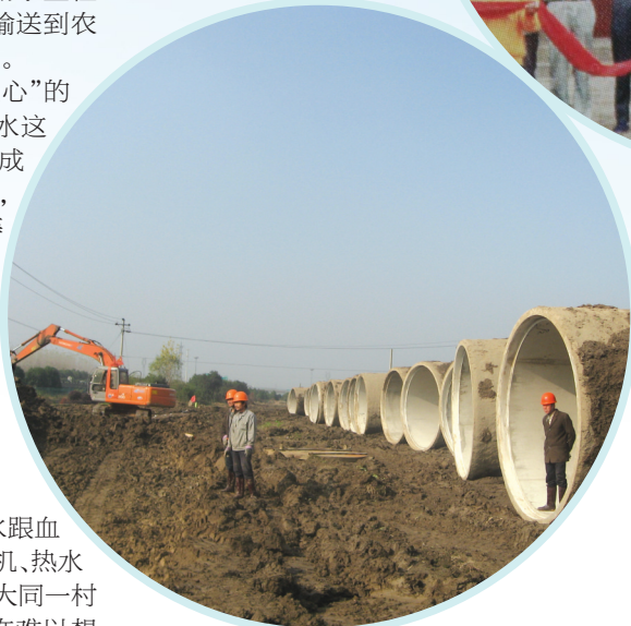
2009年,当时省内最大原水管DN2800管线工程启动建设。图为管线施工现场。
