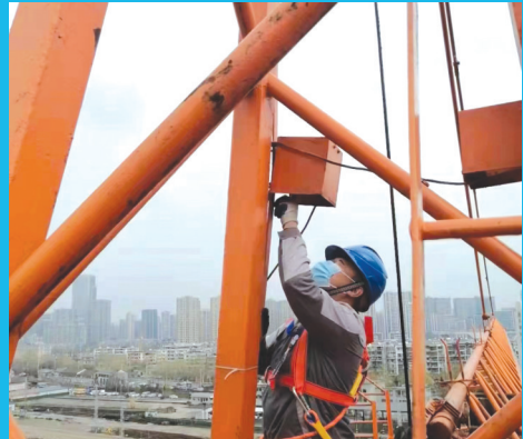
引入专业力量加强工地监管
