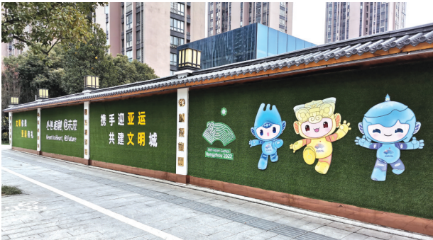
在建工地围挡美化
