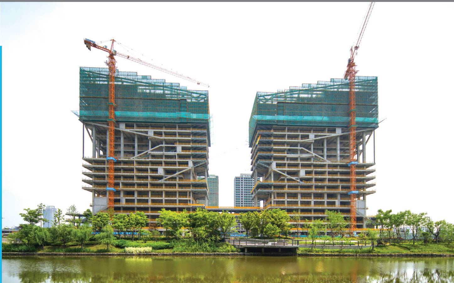
整洁有序的建筑工地
