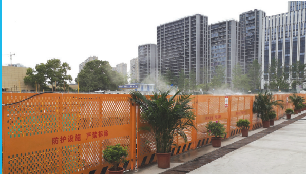
建筑工地扬尘防治措施
