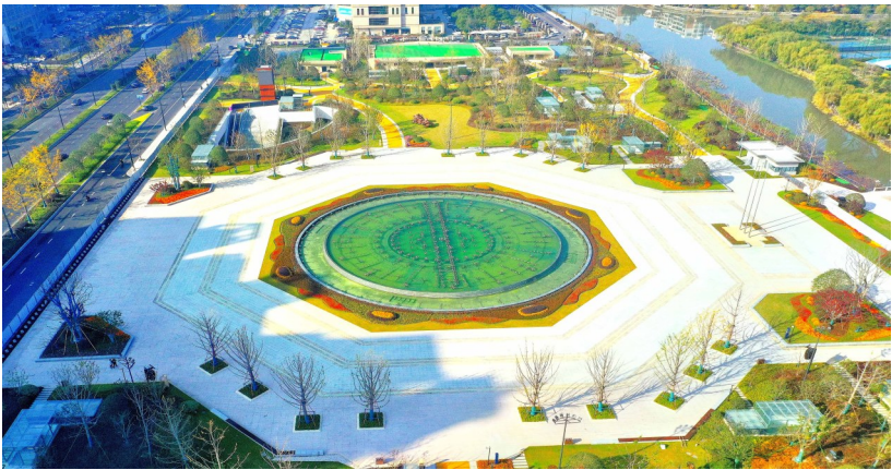
利用地下空间建设综合服务楼或停车场,人民广场综合体成为萧山城市地下空间标志性工程 记者 唐柯 摄
