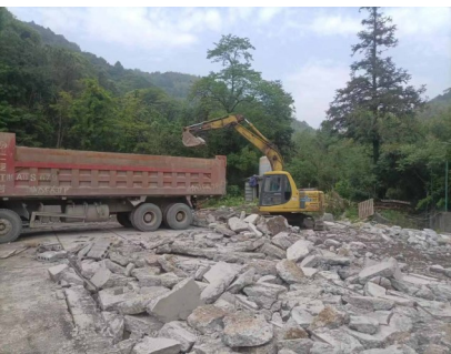
拆除硬化地面恢复耕地
