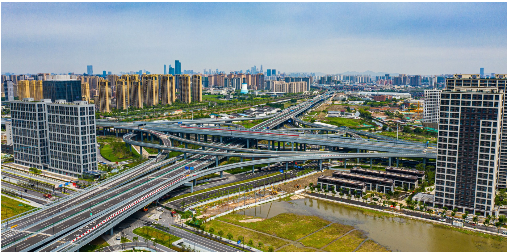
彩虹快速路和通城高架互通段
