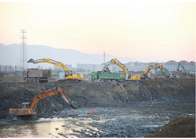
湘湖三期建设中 (摄于2015年12月17日)
