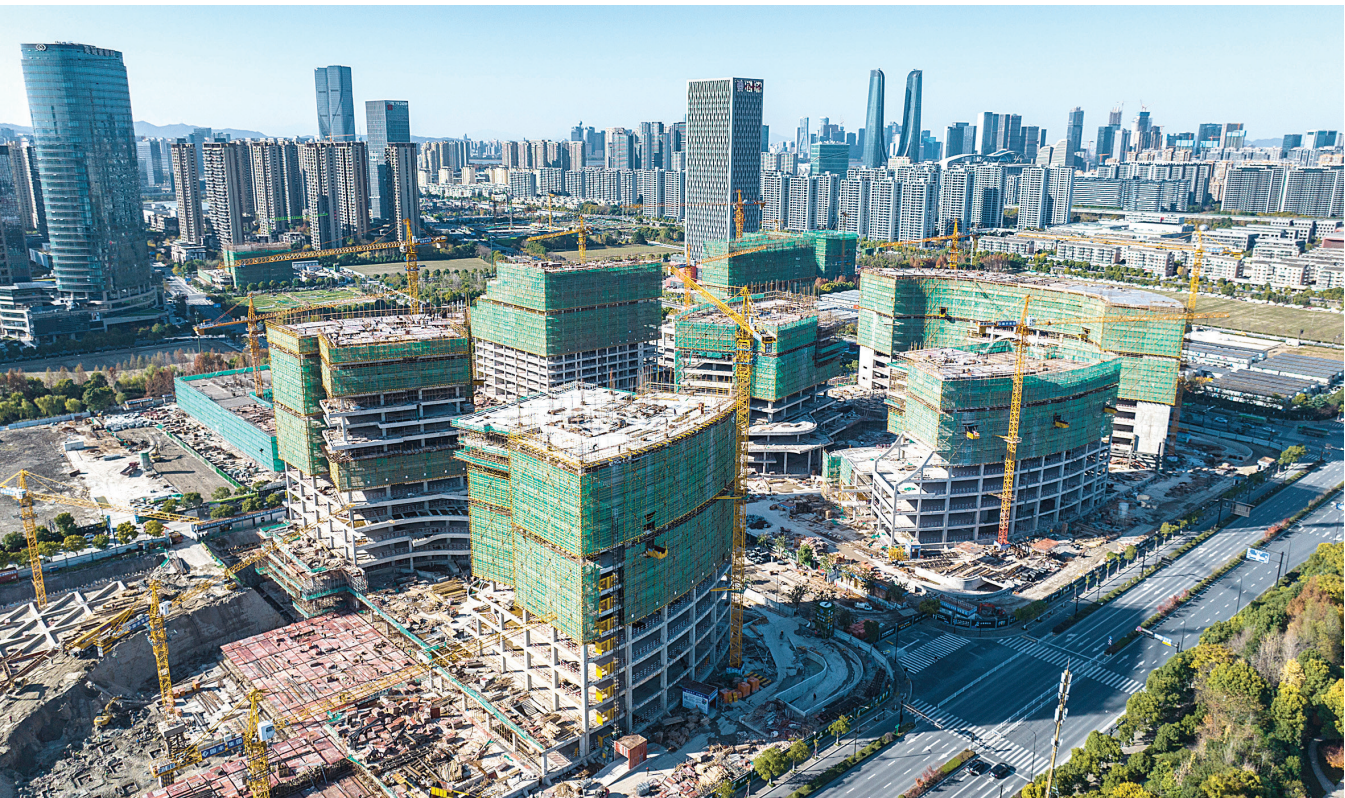
位于萧山经济技术开发区核心区域的微医国际数字健康中心项目，目前主体工程已完成60%，预计在2025年一季度完工。该中心建成后，将为2.2亿多名微医注册用户提供一站式的医疗和健康维护服务。 记者 周煜程 摄
