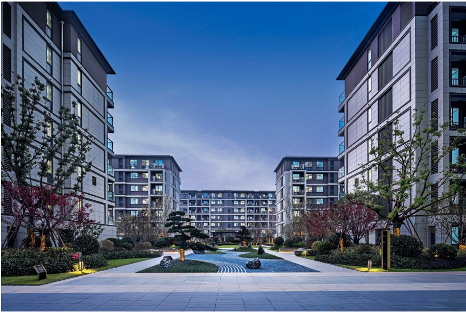
荷源府交付实景
