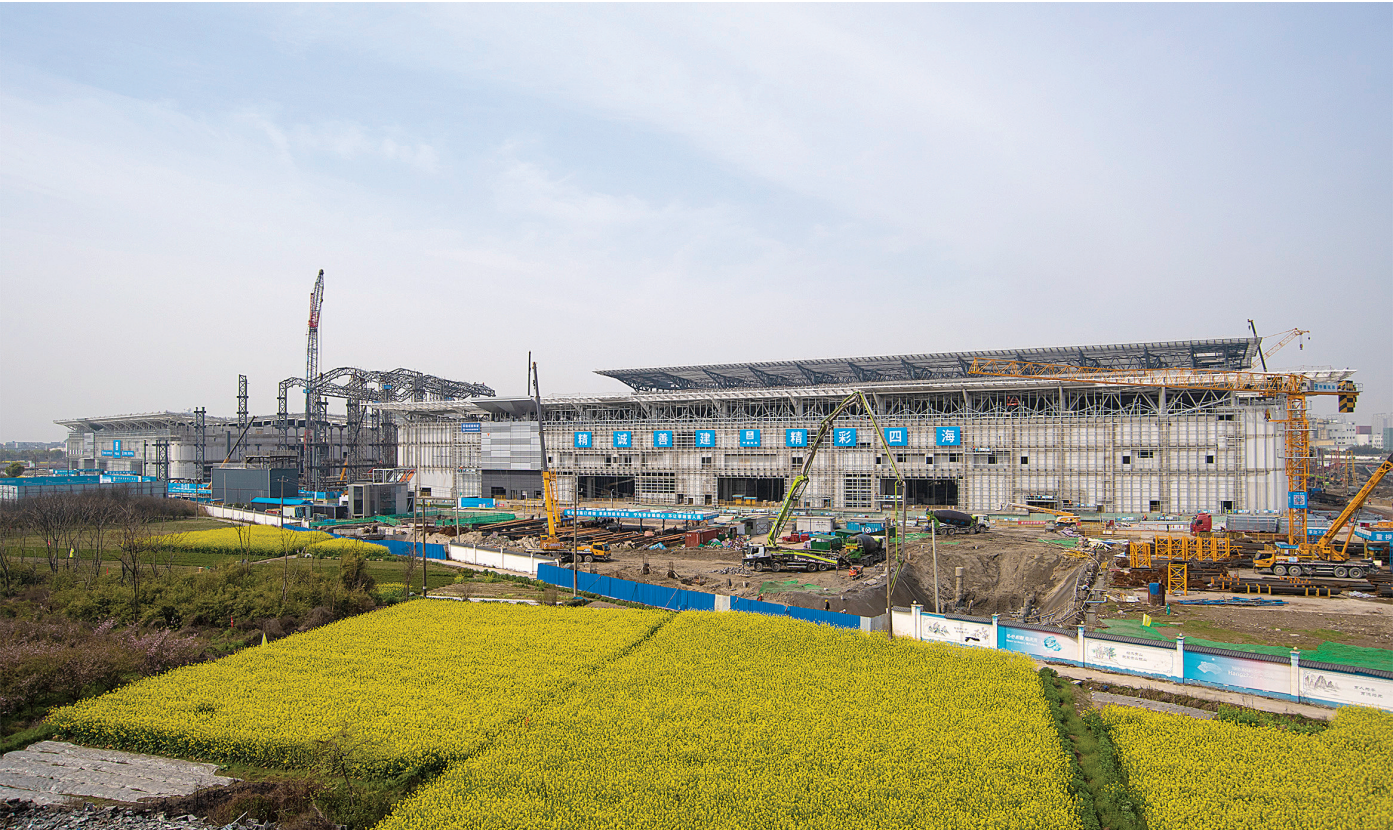
目前,位于南阳街道的杭州大会展中心一期展馆钢结构已全面结顶,展馆初现雏形,预计今年年底竣工。
