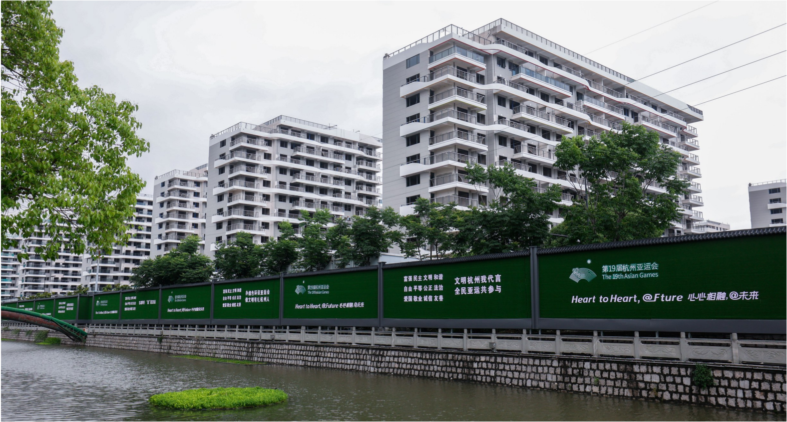
建筑工地围挡换新颜
