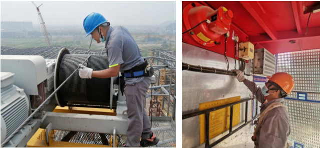
对在建工程的起重机械、爬架等设备进行检查
