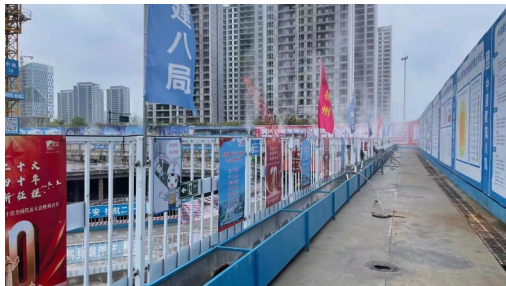
建筑工地扬尘治理
