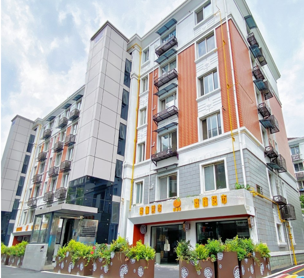
盈兴公寓加装电梯
