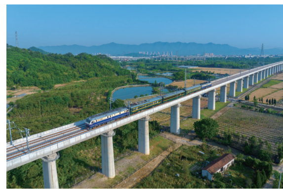
5月18日,杭州至温州高速铁路启动联调联试,进入工程验收关键阶段。杭温高铁线路全长260公里,设计时速350公里,全线设桐庐东、浦江、义乌、横店、磐安、仙居、楠溪江、温州北、温州南9个车站。该线路建成运营,对于完善区域路网布局,促进长三角城市群联动发展等具有重要意义。 图为当日杭温高铁检测列车驶过浦江特大桥。
