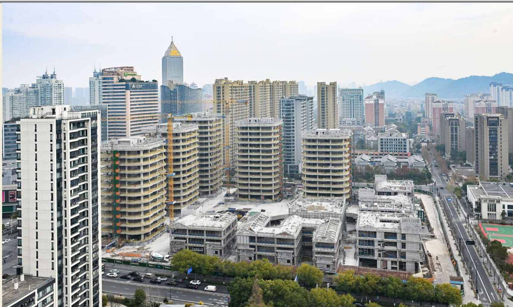
棉北里片区文创基础设施改造城市更新项目近况 2025年1月摄
