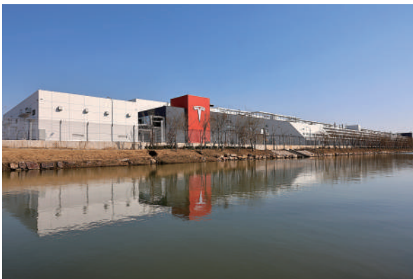
2月11日,特斯拉上海储能超级工厂在上海自贸区临港新片区正式投产。这是特斯拉在美国本土以外的首个储能超级工厂项目。历时7个月,特斯拉上海储能超级工厂于2024年12月底竣工。
