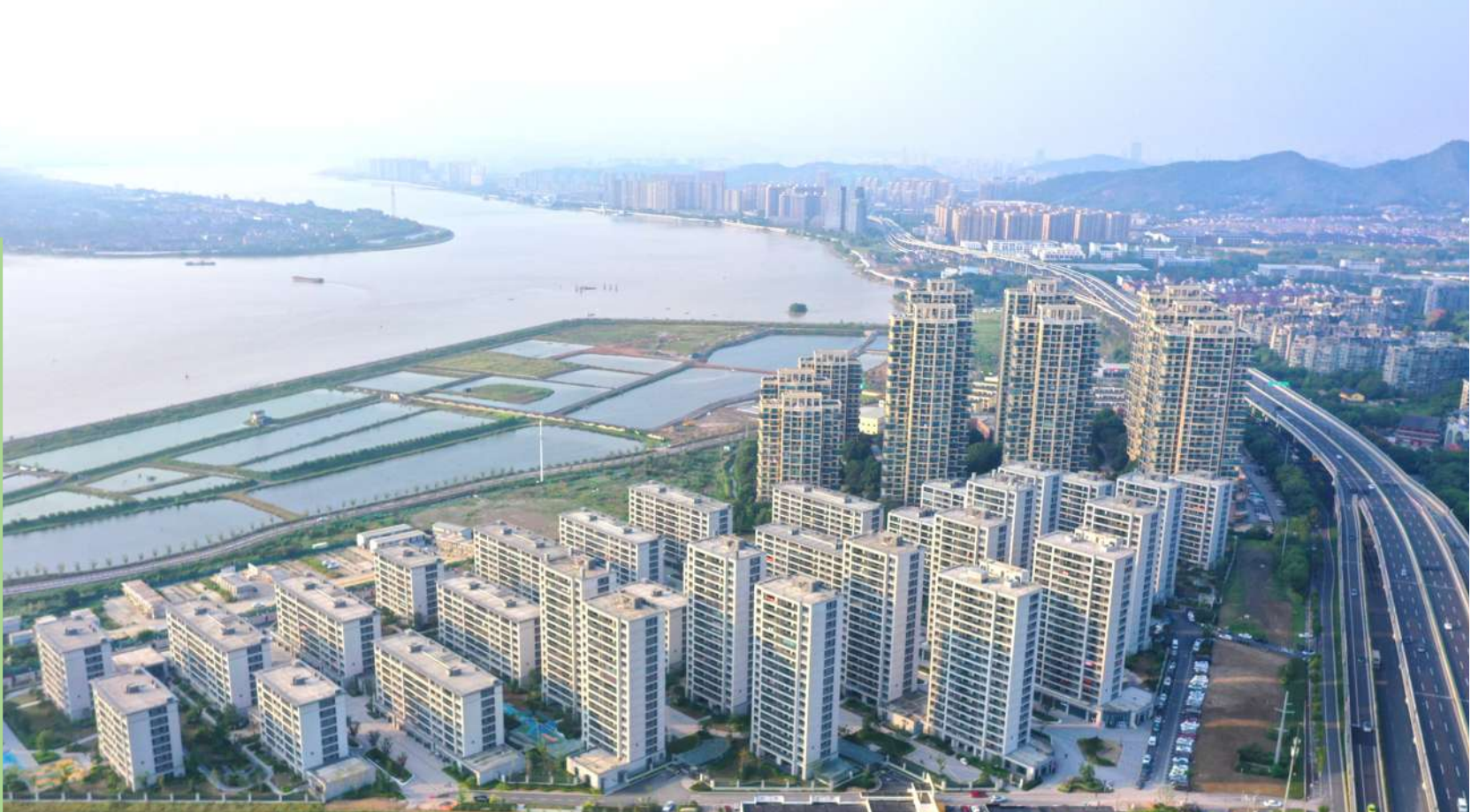
义桥镇山后村安置房项目西区(和浦山后苑)
