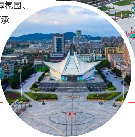
← 临浦体育馆改扩建前
