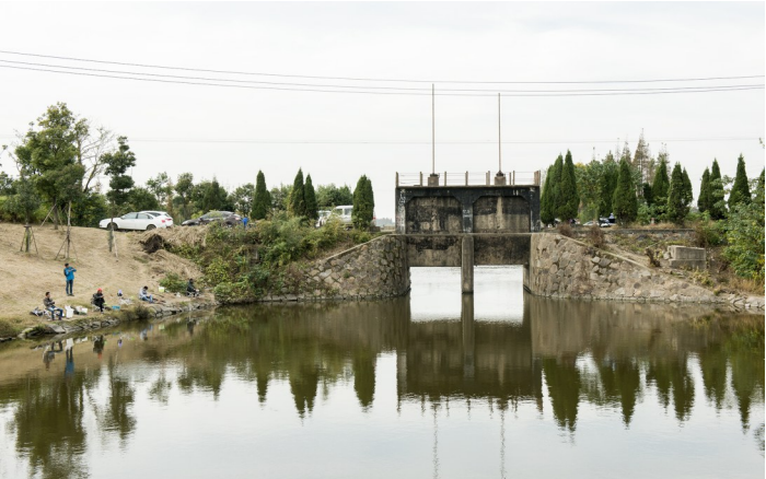
八工段 节制闸
