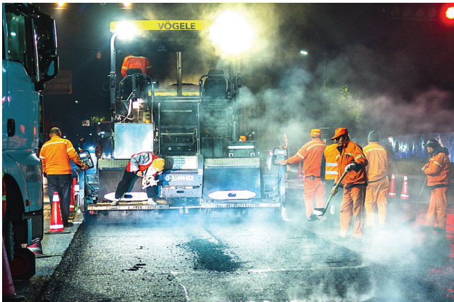
春节临近,萧山交投下属路桥工程公司利用晚上的时间,对车流量大的道路病害路段进行应急修复。图为施工人员在深夜在靖江街道的青六线与伟老线路口施工。 通讯员 王浩 摄
