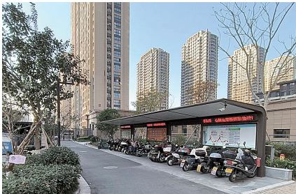
小区的公共充电桩
