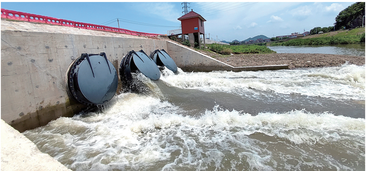
图为6月20日,我区照山机埠开机排水
