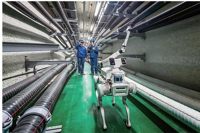
层摆放。截至目前,舱内已“入住”高压线路13回路,总长26.5公里。廊道上方布置了智能巡检机器人的行走轨道,机器人早晚固定巡检,实现管廊状态实时感知、自主预警,发现问题及时处理。感温光纤、感烟探测器、氧气传感器等智能感应设施一应俱全,实时测量各种指标。
