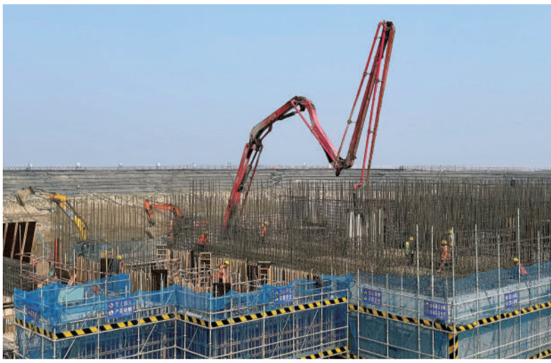
廿工段排涝闸提升改造施工现场 记者 何可人 摄
